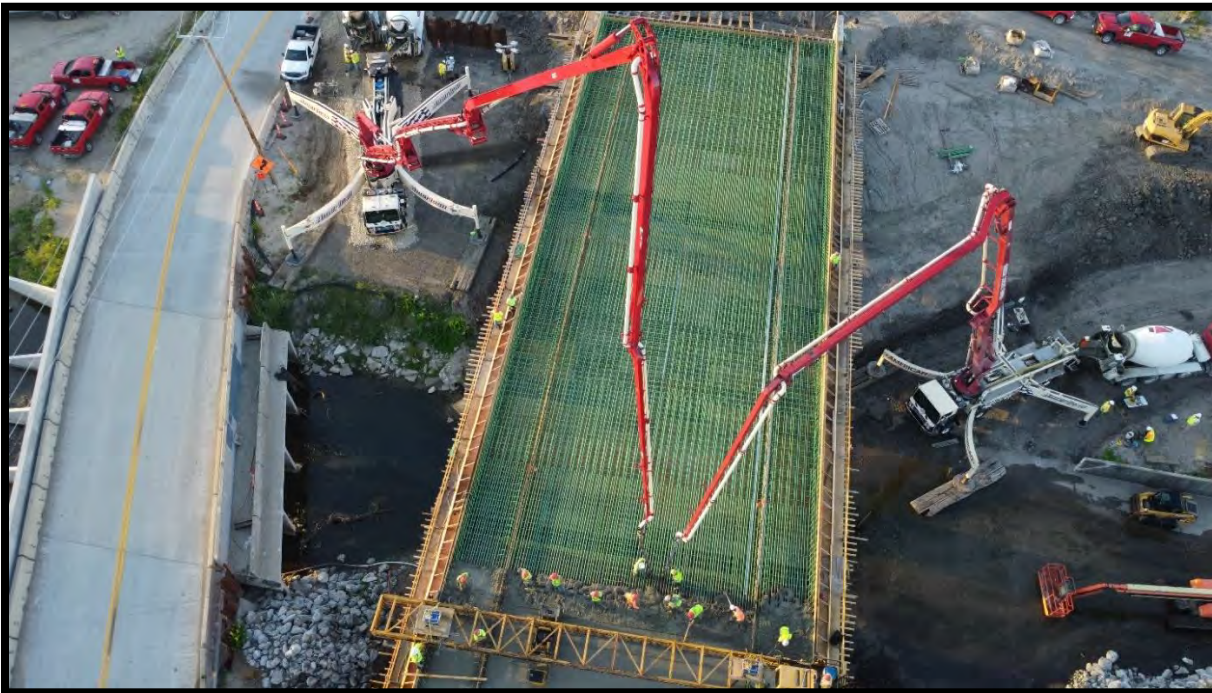
Figure 2. SHAVER ROAD NE BRIDGE POUR AUGUST 2022
